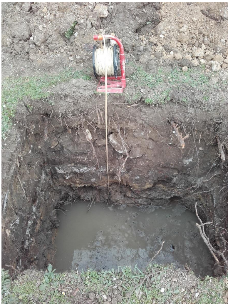
Photographie 1 : Fosse d'infiltration 1
