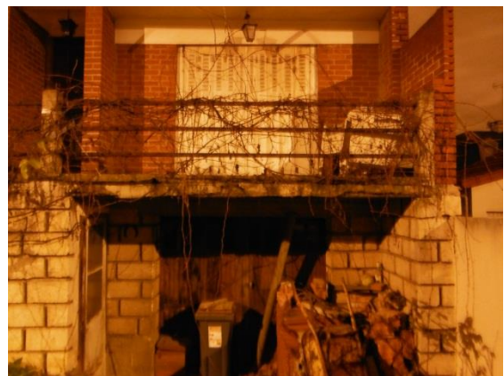
Entrée de garage encombrée rue de Dijon
