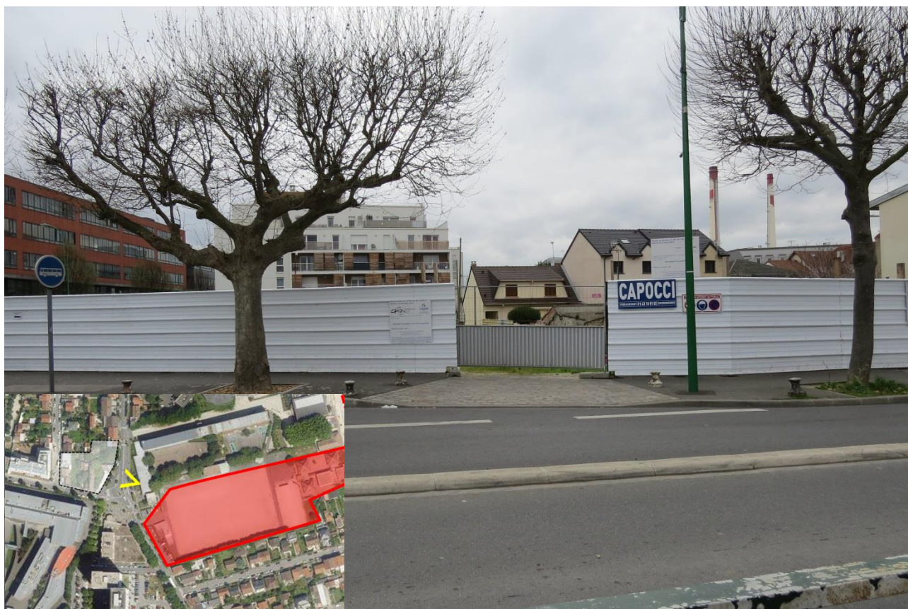
Photographie 19 : chantier en cours, rue Etienne Dolet.
