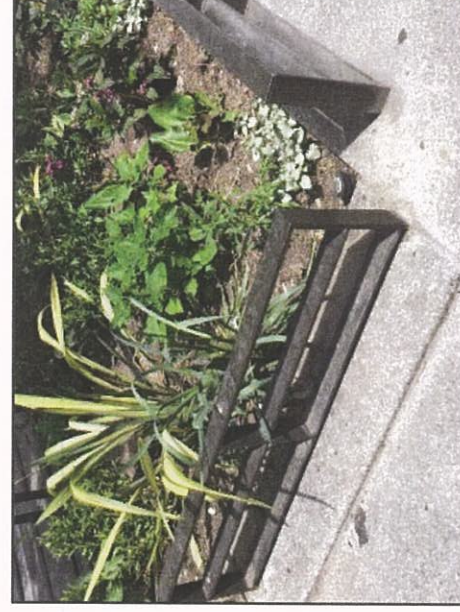
Lisse basse de protection en acier thermolaqué
